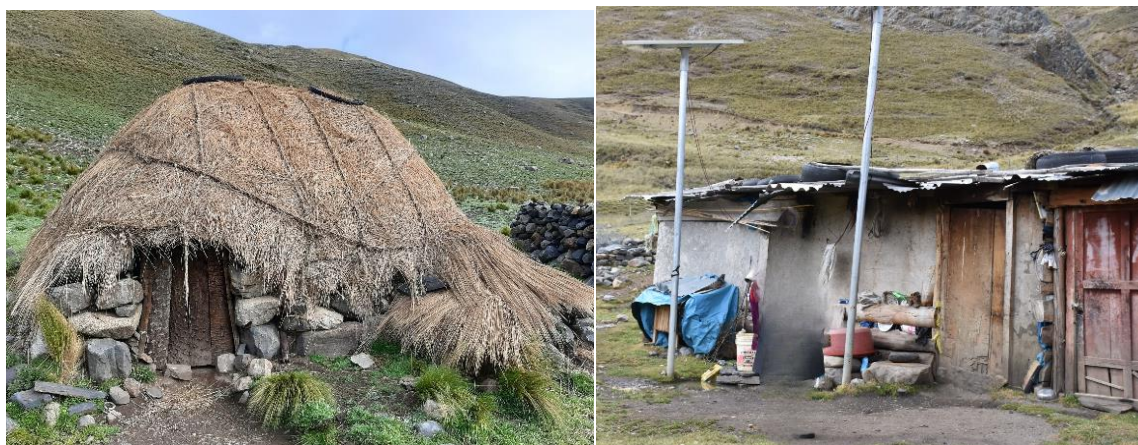
Figura 18: Tipos de viviendas en el sector de Queshque y Churana
