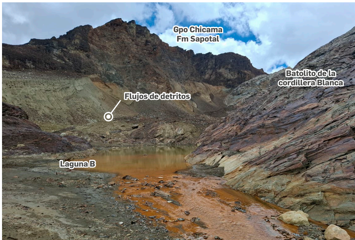
Figura 21. Flujos de detritos generados a partir de los afloramientos sulfurosos de la Formación Sapotal, los cuales se acumulan en la laguna B y favorecen la generación de drenaje ácido de roca mediante el transporte de material sulfurado.
