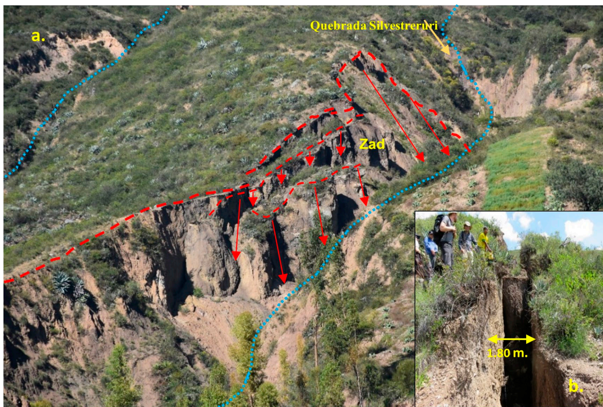
Figura 11. a) Vista frontal de la zona de carcavamiento generando asentamientos en la quebrada Silvestreruri, b) grietas con anchos aproximados de 1.80 m. Fuente: INAIGEM, 2017.
