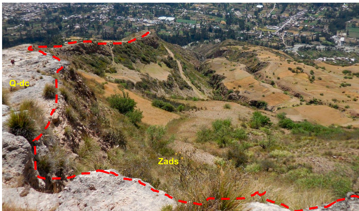
Figura 12. Zona de arranque de un deslizamiento antiguo, vista hacia el este. Obsérvese los escarpes de falla a lo largo de la línea de arranque, graficado con una línea discontinua. Fuente: INAIGEM, 2017.
