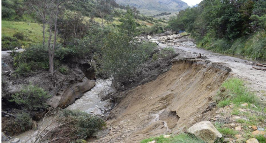
Figura 33. Afectaciones 4 y 5, Canal Cachipampa, canal de irrigación colmatado y rebasado con lodo, afectación de algunos campos de cultivo (colindante a la carretera Willcahuain - Llaca).
