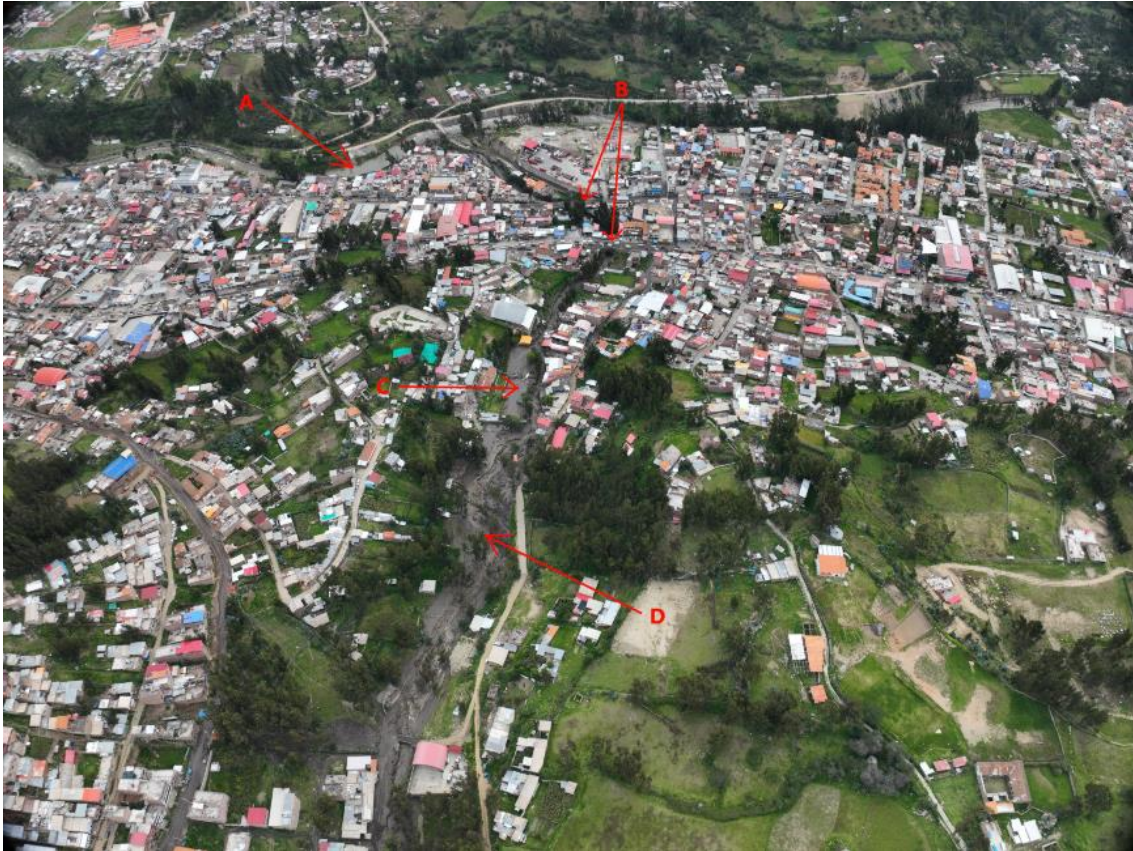
Figura 38. Afectación en el área urbana del distrito de independencia
