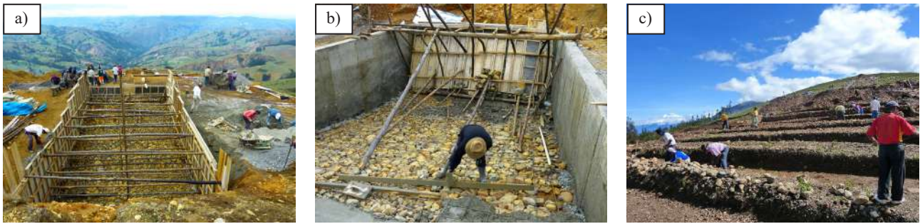
Figura 14. Proceso de construcción del sistema de biorremediación del C.U. Shallap-Huapish-Toclla: (a, b) sedimentadores y (c) humedales, setiembre-noviembre 2016. Fotos: A. Zimmer.
