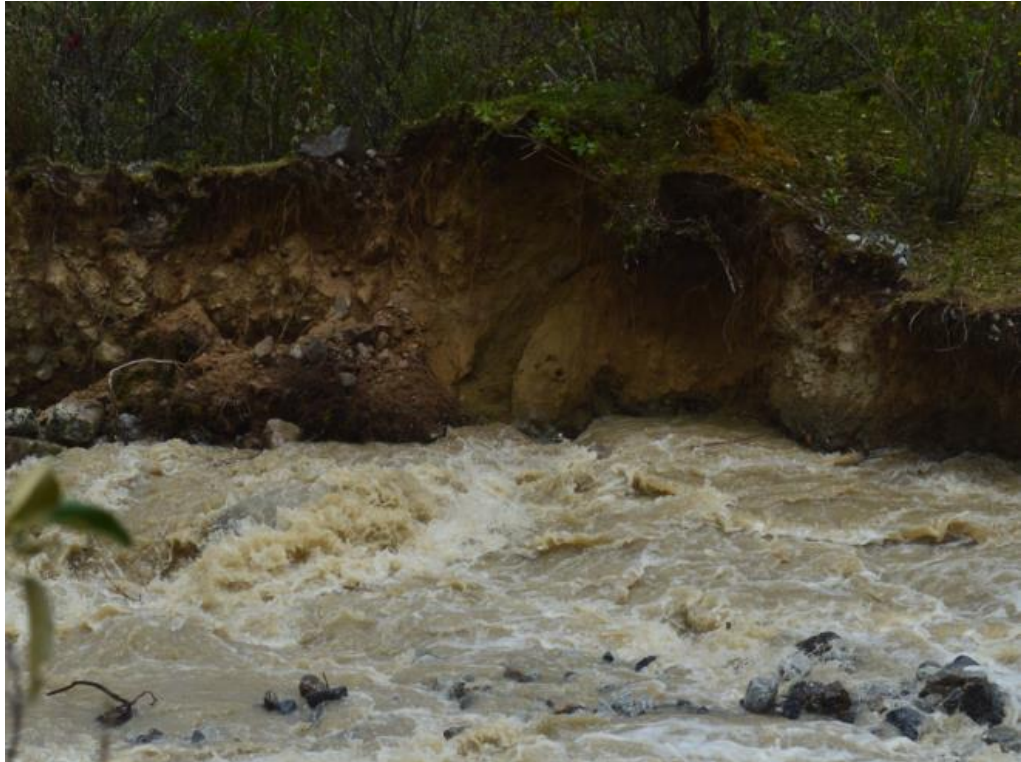
Fotografía N° 04: Erosión de los cauces del río Janca Pampa.
