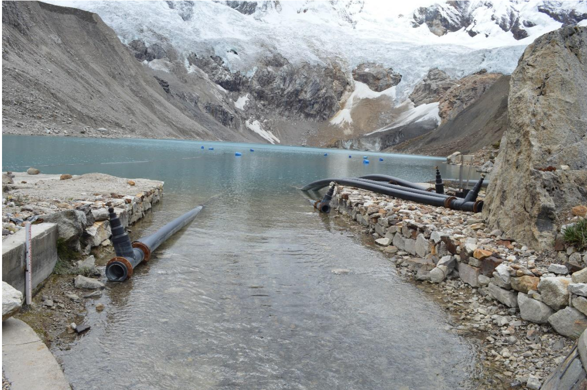
FOTOGRAFÍA N°01: Sección de salida de la laguna Palcacocha.
