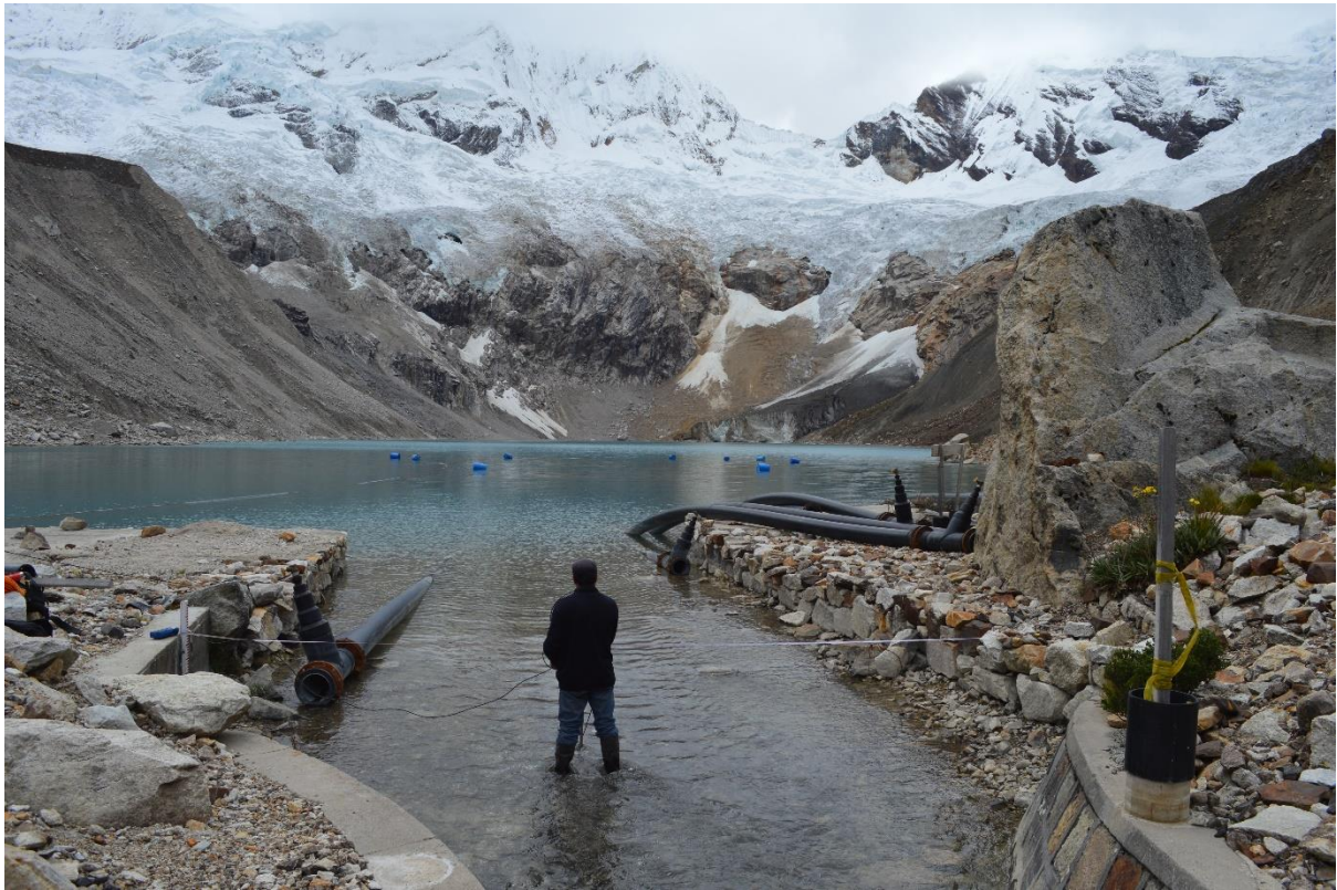
FOTOGRAFÍA N°03: Personal en labores de aforo en la sección de salida.
