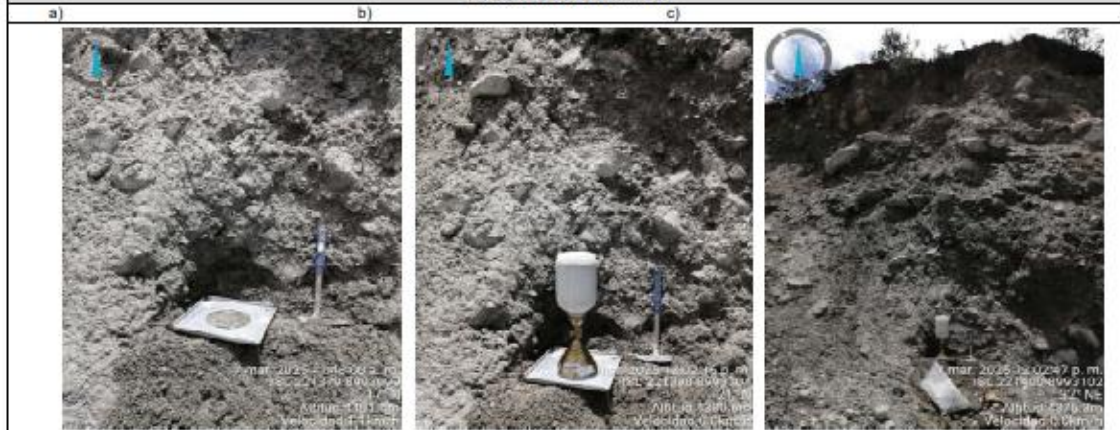
Fotografía: a) Preparación del suelo para la realización del ensayo in situ, b) Realización del ensayo de densidad, c) Vista de la morrena emplazada en la margen izquierda del canal de salida de la laguna Cancahua.
