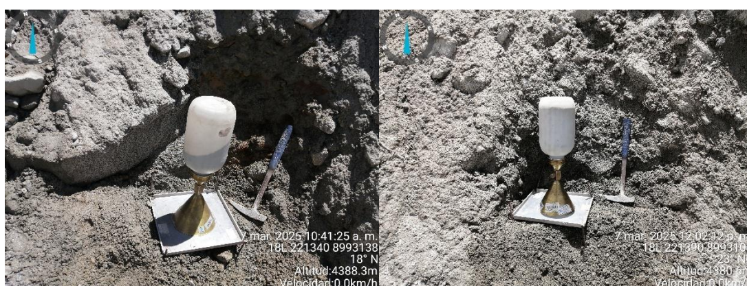
Figura 6. Toma de muestra de suelo y realización de ensayos de densidad
