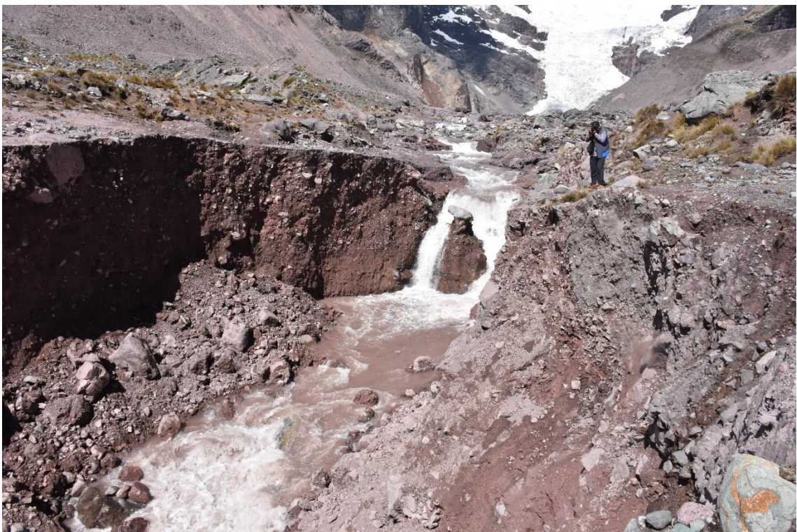
Figura 4. Erosión en el talud exterior del dique natural.
