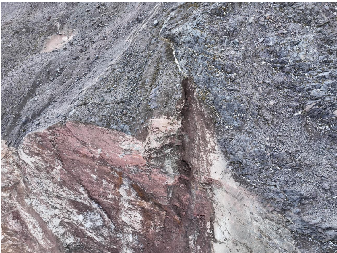
Figura 13. Zona 3, bloque en forma de cuña con agrietamiento en la parte superior y amenaza inminente.
