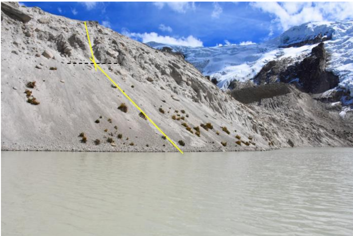
Figura 10. Flanco derecho, pendientes en el talud interior (Foto del 18/06/2021, Vilca O.)
