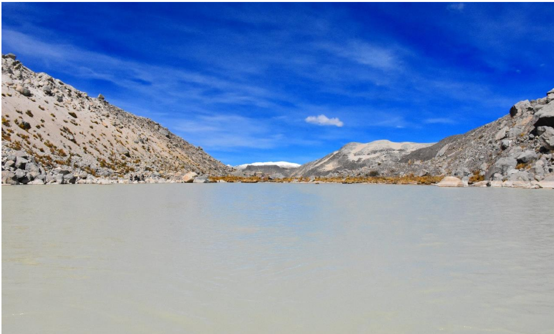
Figura 14. Zona frontal, se observa el mismo nivel rasante del espejo de agua de la laguna Ananta Cucho y la corona del dique (Foto del 18/06/2021, Vilca O.)
