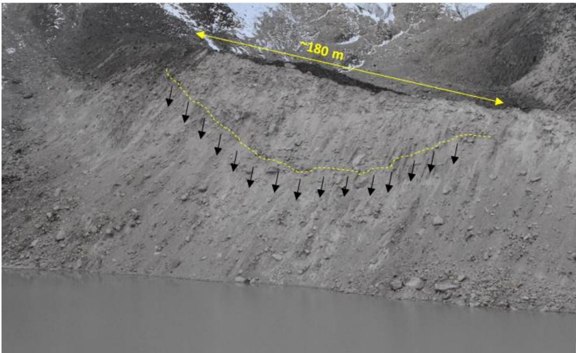
Figura 13. Flanco izquierdo, se delimita la zona crítica con potencial a deslizamiento (Foto del 18/06/2021, Vilca O.)
