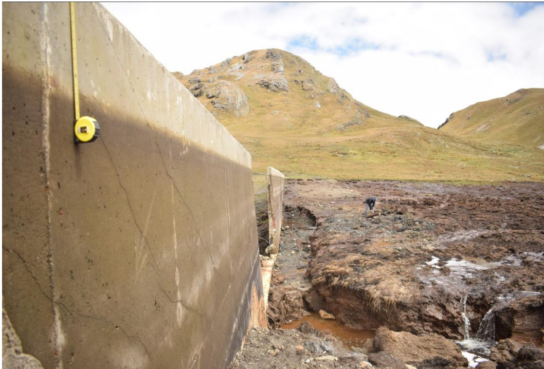
Figura 15. Zona de rotura de muro de contención.
