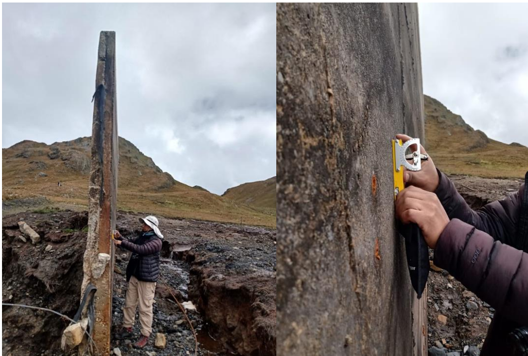
Figura 17. Zona de rotura de la presa - se visualizan inclinación del muro de hacia la parte interna de la presa en 7°.
