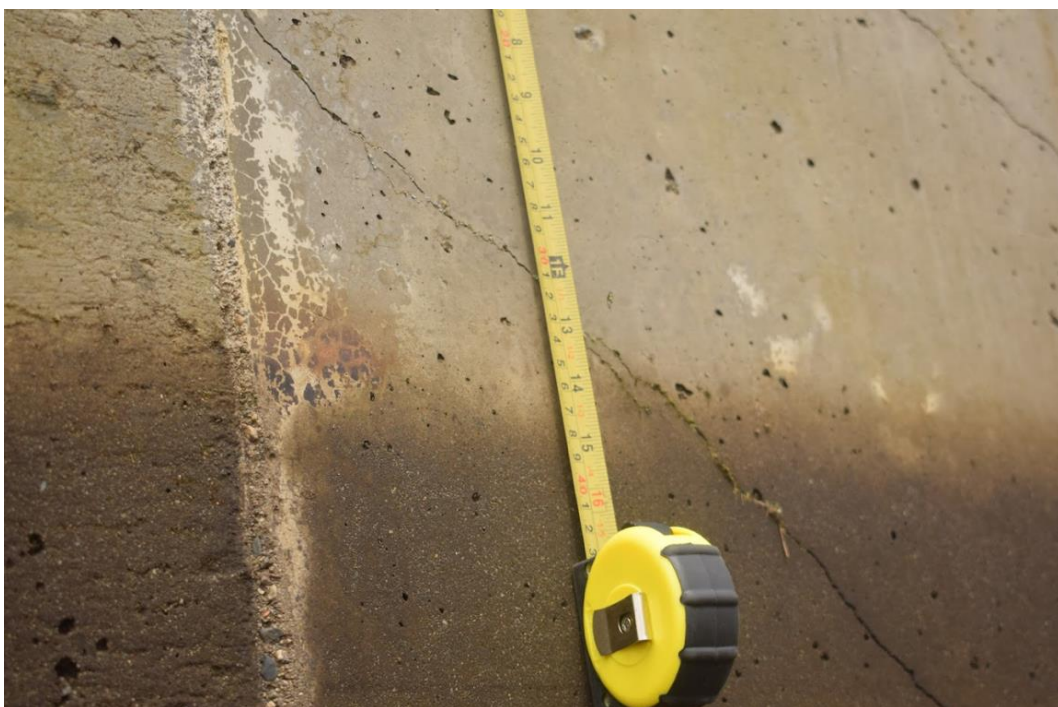
Figura 15. Zona de rotura de muro de contención.
