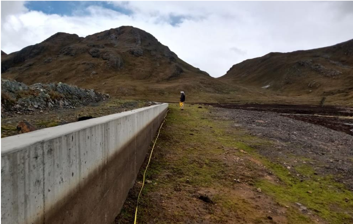
Figura 11. Vista parcial del margen derecho de la presa y laguna Platococha.
