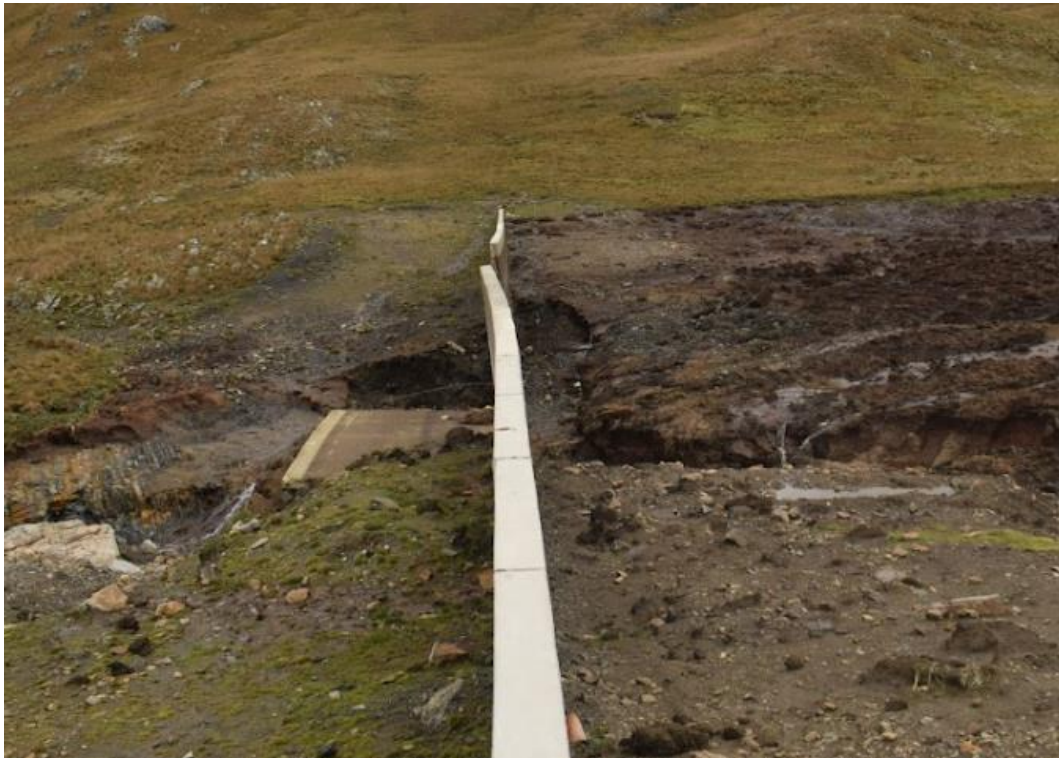
Figura 17. Zona de rotura de la presa - se visualizan inclinación del muro de hacia la parte interna de la presa en 7°.
