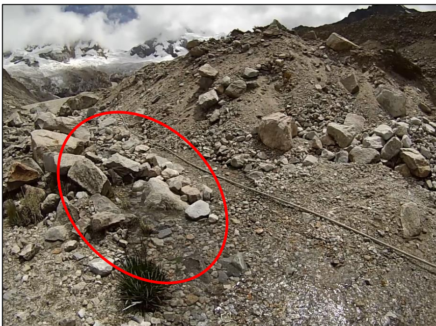
Fotos N°04 , Vista de la primera filtración ubicada cerca al dique llamado auxiliar de la laguna.
