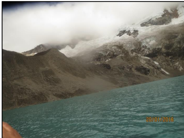
Foto N°09. Se observa en casi todo el talud la presencia de humedad producto de la fusión ejercida por el glaciar
