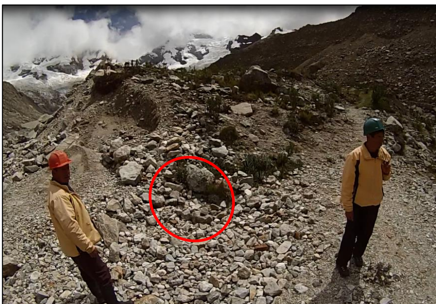
Fotos N°05 , Vista de la segunda filtración ubicada cerca al centro del dique morrenico de la laguna.
