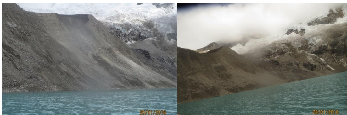
Foto N°20. Considerado sector crítico producto de la alta humedad que existe y a raíz de ello los movimientos de masas de suelos que se han presentado, la ubicación entre el glacial y la morrena le dan una estructura en cuña que característica de probable inestabilidad.
