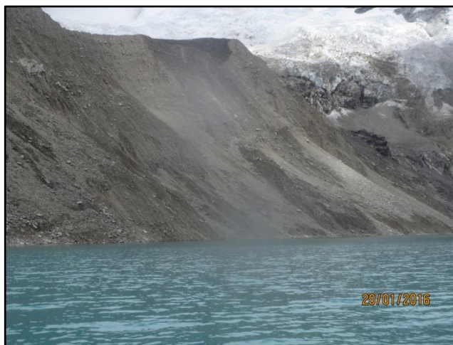
Foto N°11. Considerada como sector crítico, debido a la alta humedad que ha saturado el suelo, además de ubicarse entre el glaciar y morrena generando una estructura en cuña.
