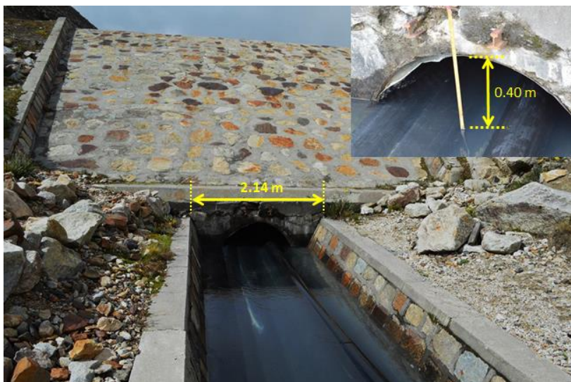
Foto N°23, Vista del ducto de desagüe del dique, mostrando los escasos 40 cm de borde libre del ducto.
