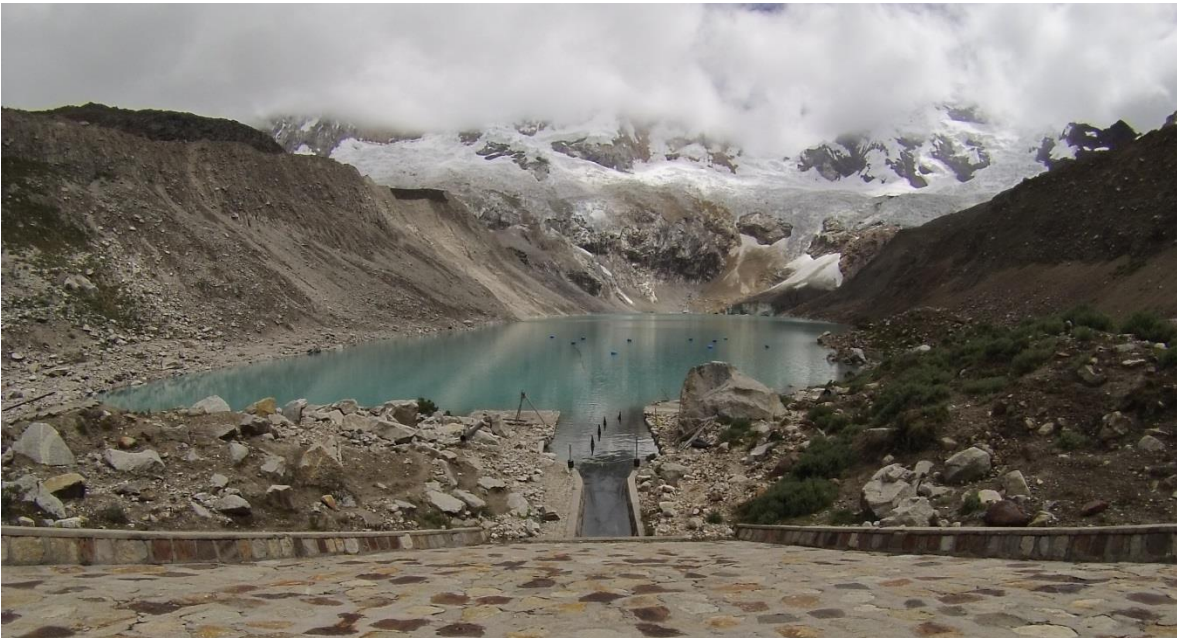
Foto N°01 , Vista del Dique principal de la laguna Palcacocha.
