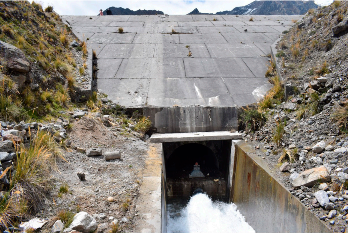
Figura 16. Presa de seguridad emplazada en la laguna Lazuntay, revestida de concreto, con canales de salida y estructura de rebose
