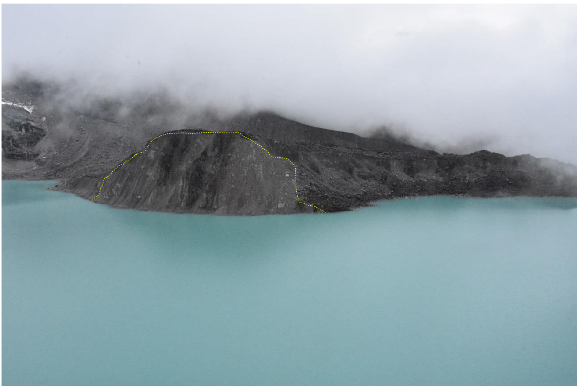
Figura 6. Flanco izquierdo, en donde se señala la zona con mayor actividad erosiva (INAIGEM/ O. Vilca, 20/10/2020)
