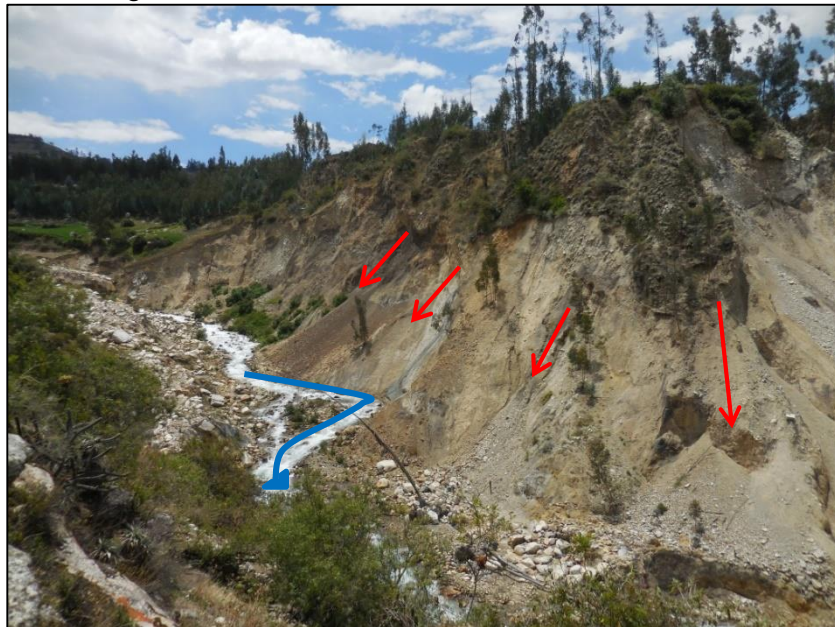
Fotografía N° 67: Derrumbes locales de material cuaternario.
