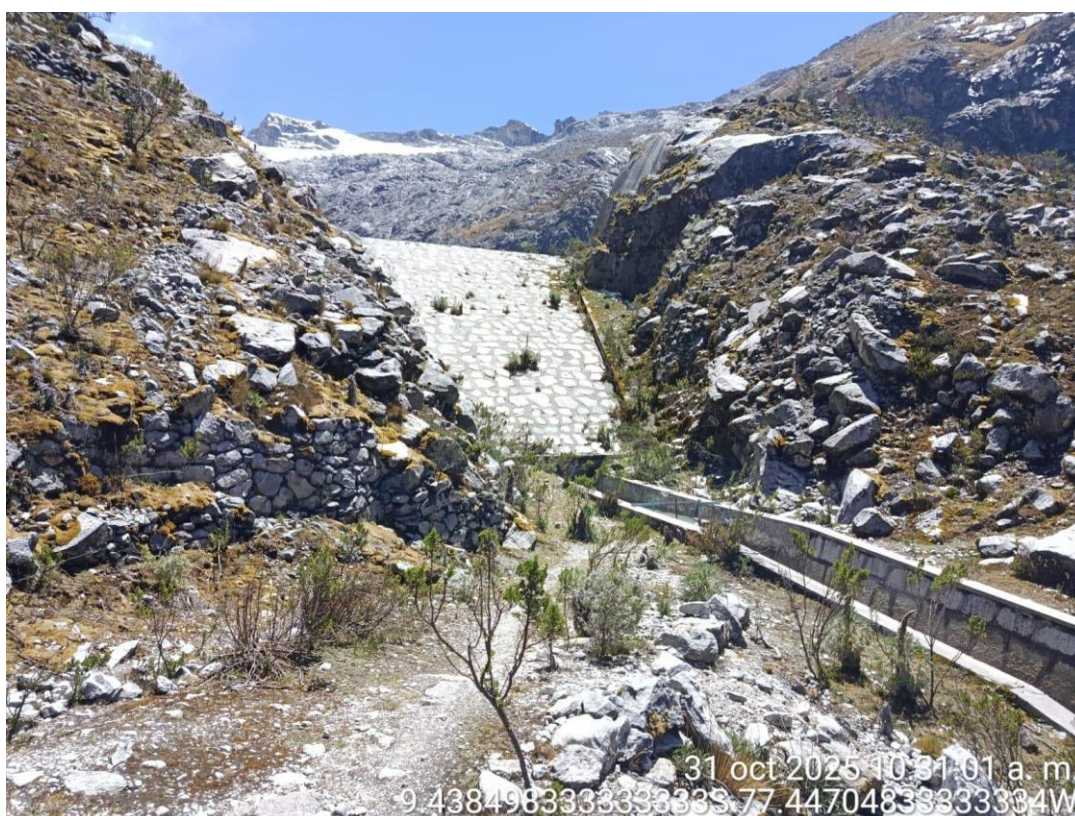
Figura 21. Vista frontal del dique de tierra de la laguna Llaca
