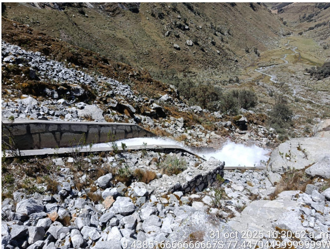
Figura 22. Vista del canal de salida y de la rápida
