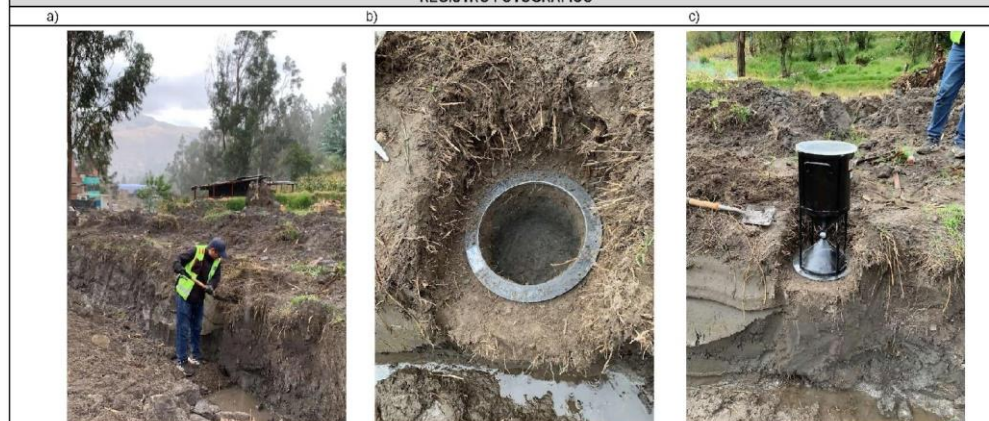
Fotografía: a) Preparación del suelo para la realización del ensayo in situ. b) Extracción de la muestra representativa de suelo. c) Realización del ensayo de densidad.
