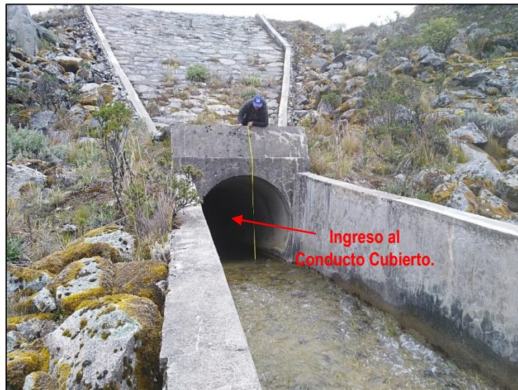
Fotografía N° 19: Zona de ingreso al conducto cubierto, visualizándose el estado del mismo.
