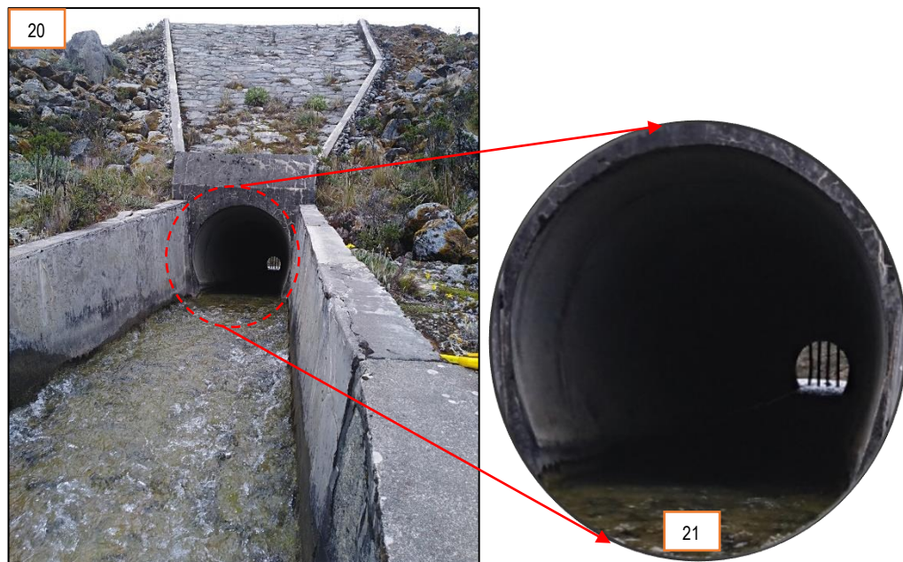
Fotografía N° 20 y 21: Conducto cubierto, visto desde la zona de salida.
