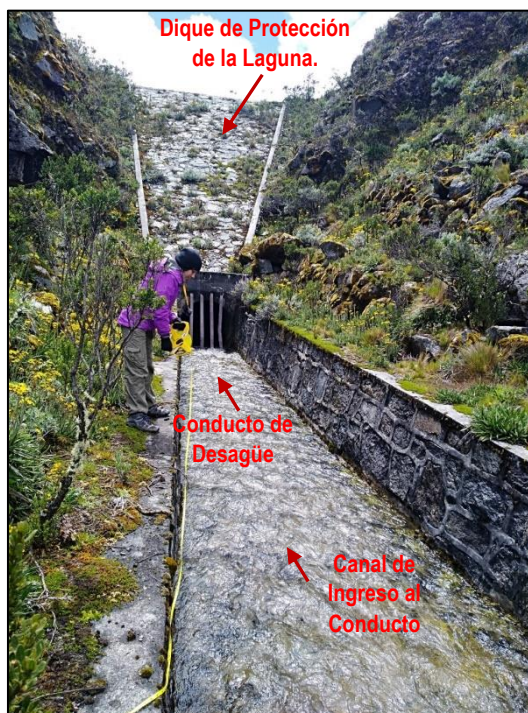
Fotografía N° 10: Obras de Seguridad de la Laguna Allicocha
