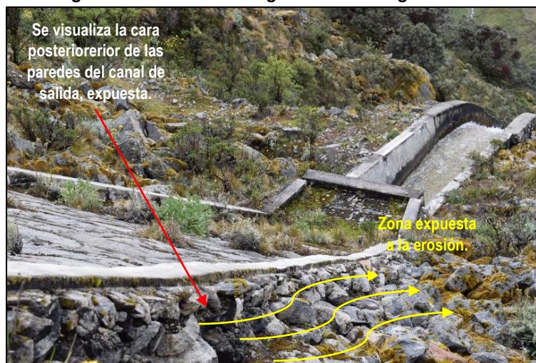
Fotografía N° 22: Obra de Seguridad de la Laguna Allicocha
