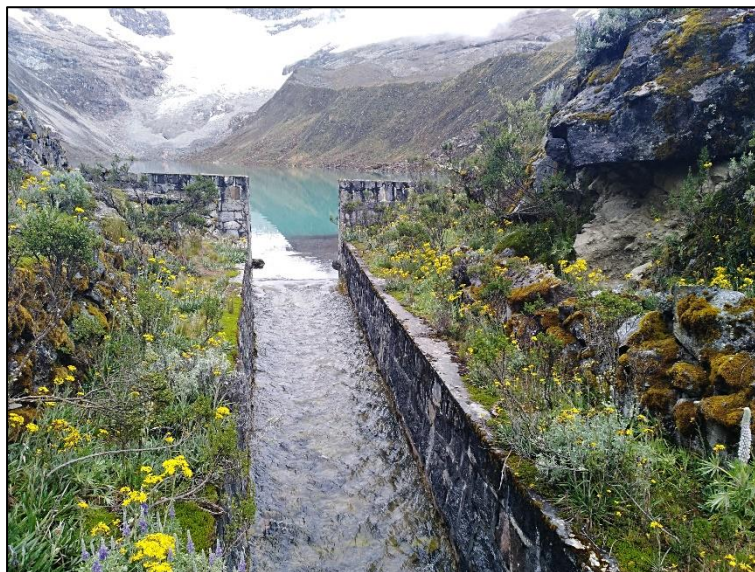
Fotografía N° 16: Canal de Ingreso al conducto de desagüe de la laguna Allicocha.
