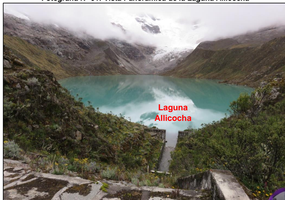
Fotografía N° 01: Vista Panorámica de la Laguna Allicocha
