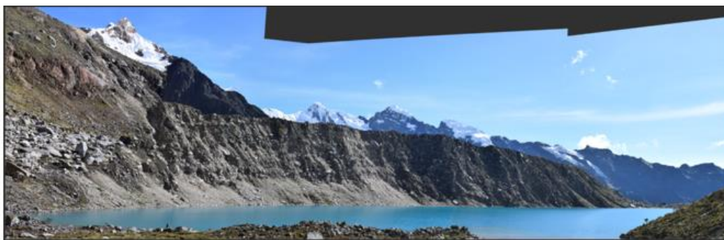
Fotografía N°3: Se muestra la morrena lateral izquierda con los procesos de deslizamientos existentes en la laguna.
