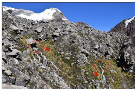
Fotografía N°7: Se muestra las filtraciones en la morrena terminal de la laguna Cancarcá.
