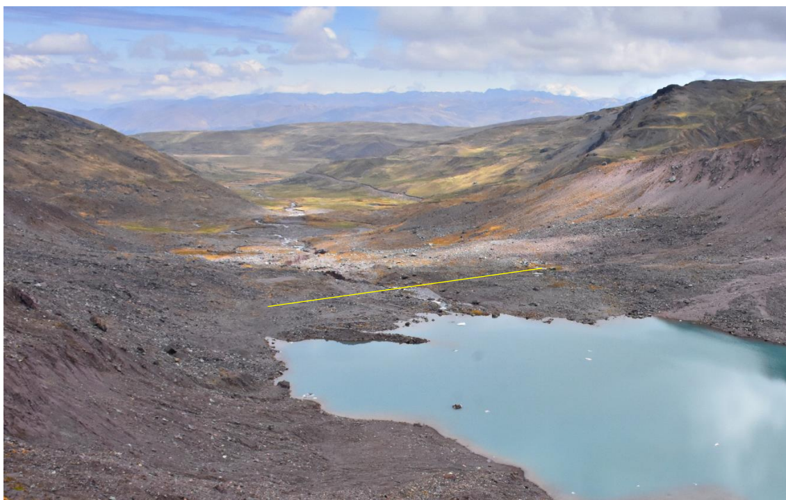
Figura 9. Zona de frontal y de rebose, en línea amarilla, la propuesta tentativa (sujeta a estudios detallados) para la ubicación de un dique artificial que garantice un borde libre de seguridad (INAIGEM/O. Vilca, 02/11/2020).
